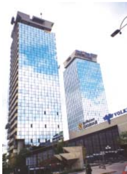
Poslovni center Unis, opremljen z izdelki IMP Klime
