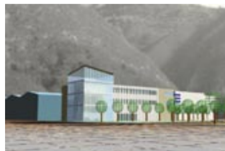
V tolminskem razvojno-tehnološkem centru se bodo poleg prostorov vodstva družbe AET in razvojnih inženirjev nahajali prostori za trajnostne teke končnih izdelkov, prostori za testiranje posameznih komponent in materialov ter prototipne delavnice.
