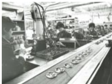
V tolminskem tozidu so ob tekočem traku konec 70. let montirali osnovne plošče magnetnih vžigalnikov.
