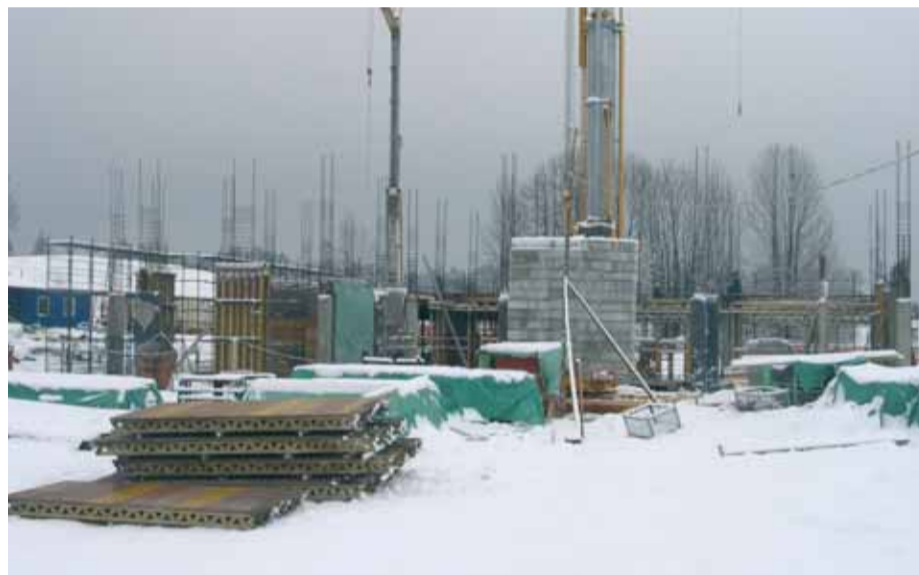
Gradbena dela, ki so se začela novembra 2004, so bila januarja 2005 kljub snegu v polnem teku.
